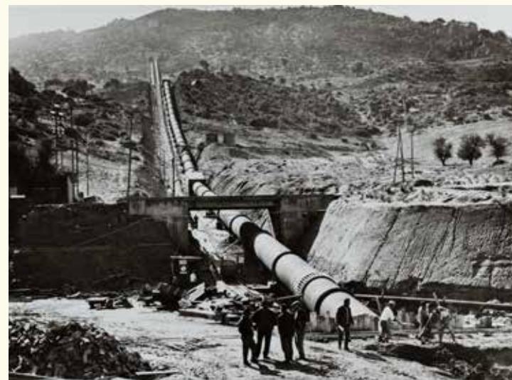
Construção de uma central hidroelétrica em Taloro, Sardenha (Itália). HAEU, BEI 2154 - Photo Unknown.
