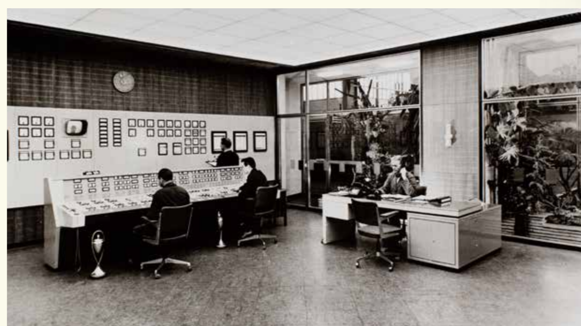
BEWAG, o centrală termică din Berlinul de Vest (Germania), cca.1977. HAEU, BEI 2164 – Photo: Unknown.
