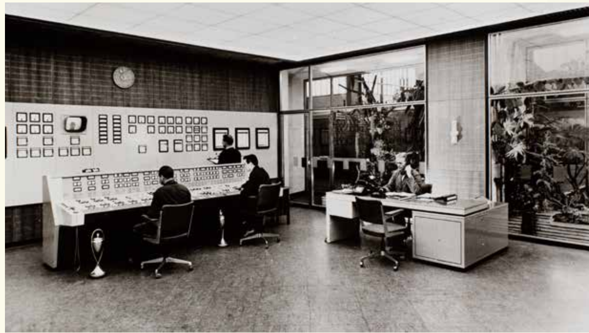
BEWAG, tcentral termoelectrica em Berlim Ocidental (Alemanha), cerca de 1977. HAEU, BEI 2164 – Photo: Unknown.
